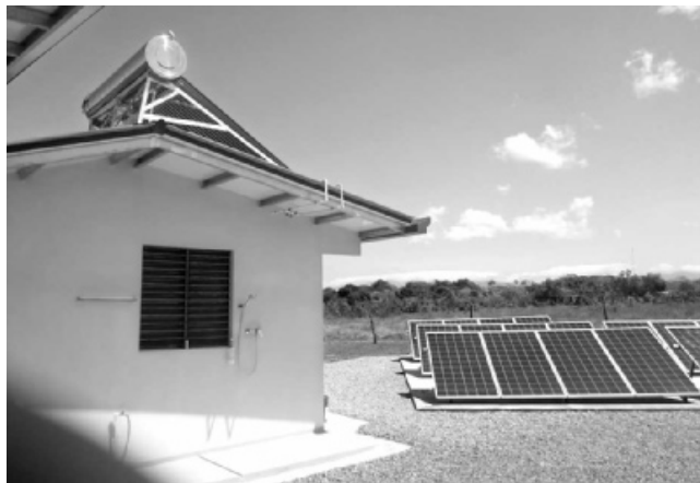
Unabhängigkeit durch Stromversorgung mit der eigenen Solaranlage
